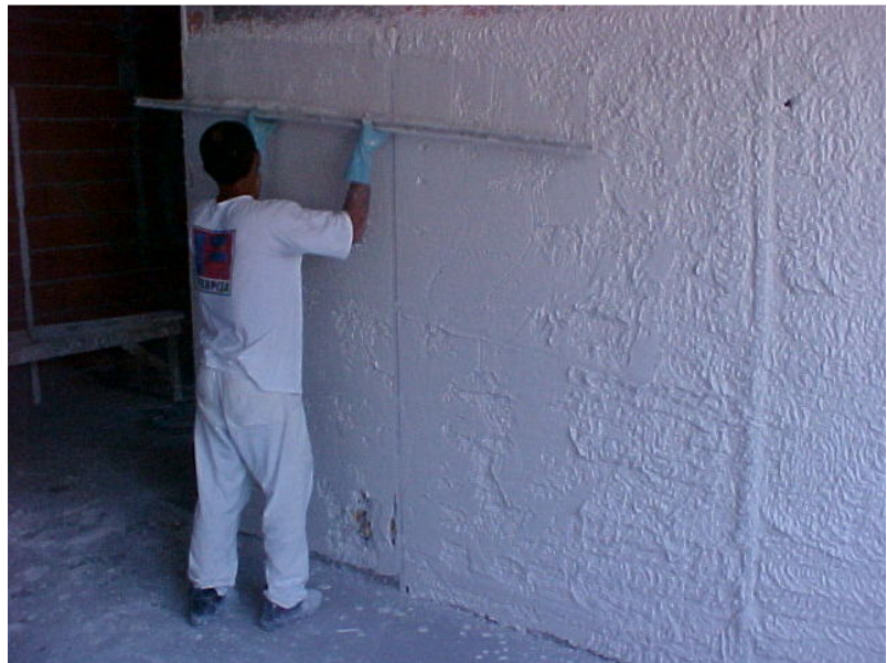
Figuras 9 – Sarrafeamento de massa de gesso projetada.
