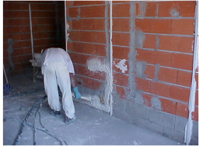
Figura 3 e 4- Início da aplicação do produto através da máquina projetora que mistura e bombeia produto na parede, a aplicação é rápida e , este apresenta-se mais líquido que o gesso comum.
