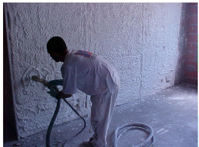
Figuras 5, 6, 7 e 8 – Projeção de massa de gesso – processo rápido e com pouca massa desperdiçada.
