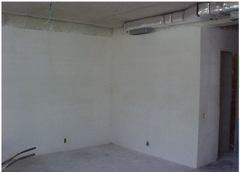
Figura 10 – Parede com aplicação de argamassa de gesso 100% concluída – Obra limpa e com baixo desperdício.
