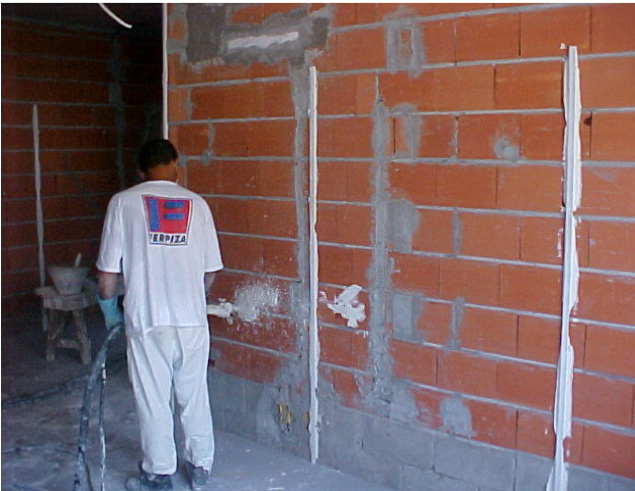
Figura 3 e 4- Início da aplicação do produto através da máquina projetora que mistura e bombeia produto na parede, a aplicação é rápida e , este apresenta-se mais líquido que o gesso comum.
