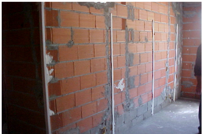
Figura 2 – Colocação das mestras de alumínio que vão ajudar na regularidade e planicidade das paredes
