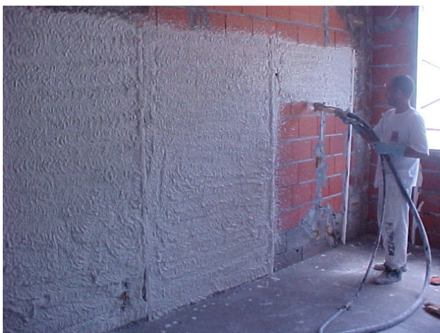
Figuras 5, 6, 7 e 8 – Projeção de massa de gesso – processo rápido e com pouca massa desperdiçada.
