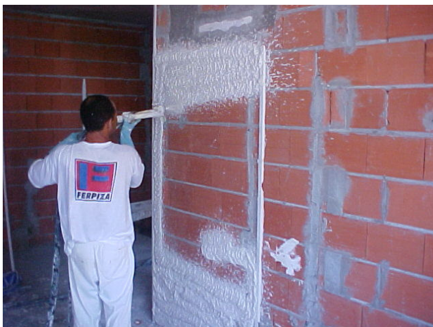
Figura 3 e 4- Início da aplicação do produto através da máquina projetora que mistura e bombeia produto na parede, a aplicação é rápida e , este apresenta-se mais líquido que o gesso comum.
