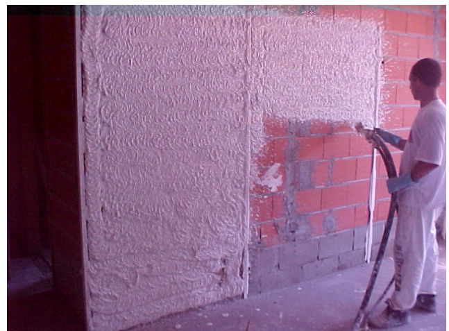
Figura 3 e 4- Início da aplicação do produto através da máquina projetora que mistura e bombeia produto na parede, a aplicação é rápida e , este apresenta-se mais líquido que o gesso comum.
